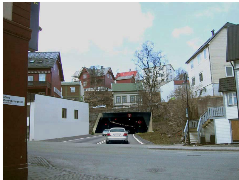
Havnegata med tunnelinslag
