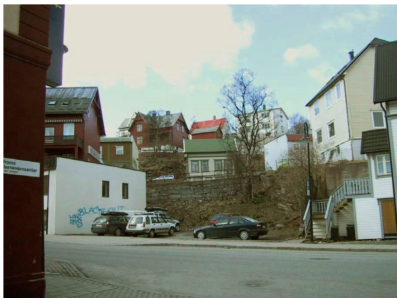
Havnegata eksisterende situasjon
